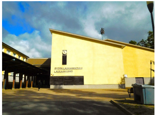
図4 シダン ラウカー学校の校舎 (外観)
